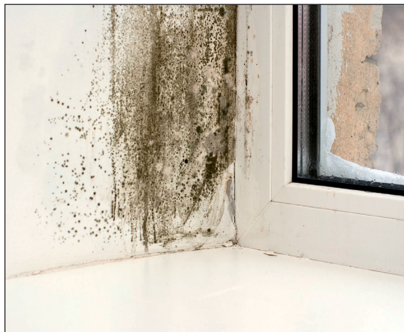
Figura 1 - Esempi tipici di formazione di muffa in prossimità di un ponte termico, a sinistra, ed in prossimità del giunto parete/finestra (immagine tratta dal sito internet www.gruppoprogettazione.it )
